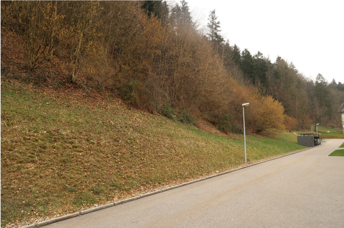
Foto 1: Hangböschung mit Bestockung aus nördlicher Richtung. Durch selektive Auslichtung fällt Holzmaterial an, das für die Erstellung von Kleinstrukturen entlang dem Gehölzrand verwendet werden kann.
